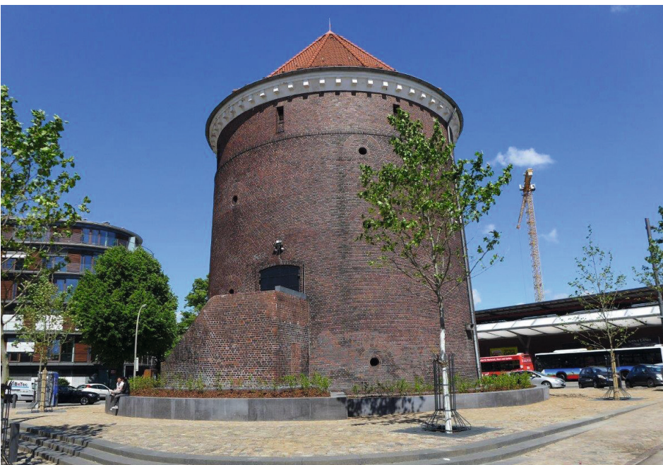
Abb. 20 – Historischer Rundbunker nach der Neugestaltung der Freianlage
