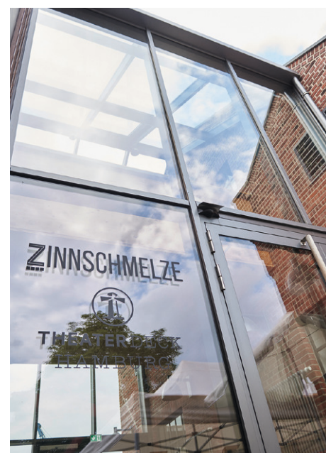
Abb. 16 – Der neue gläserne Zwischenbau
