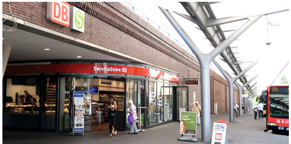
Abb. 11 – Einer der neuen Zugangsbereiche des Bahnhofs
