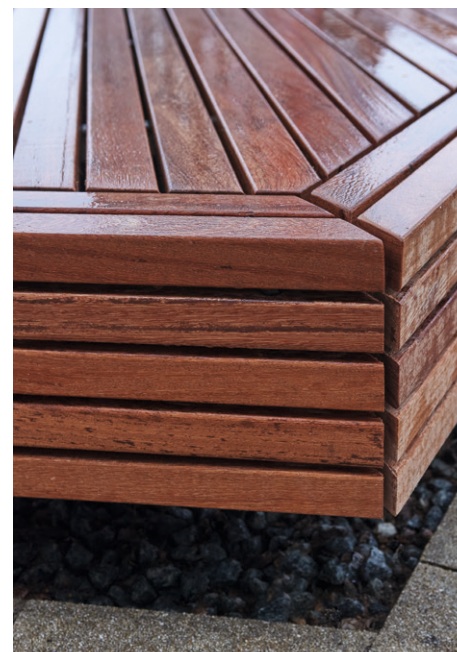
Abb. 34 – Holzdecks im Detail
