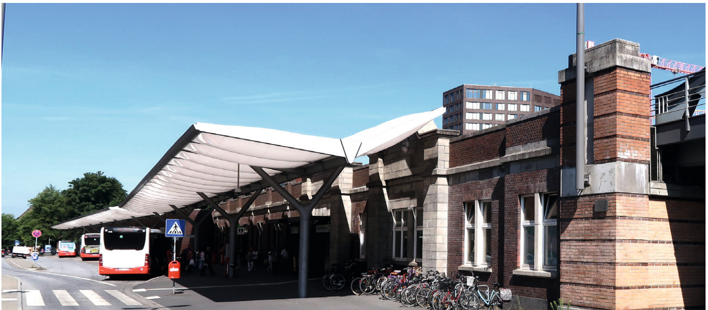
Abb. 12 – Die neue Überdachung des Bahnhofs
