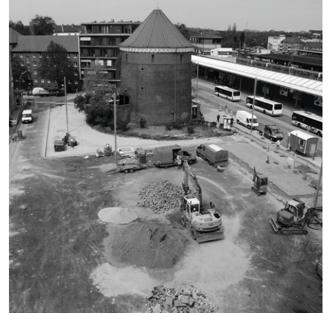
Abb. 17 – Bauarbeiten auf dem neuen Stadtplatz
